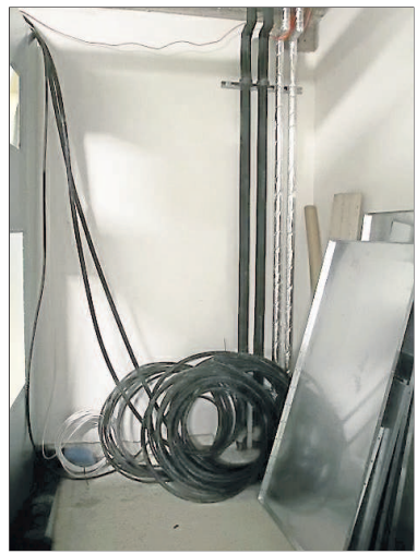
Viel Strom: Starke Kabel werden verlegt, um den MRT zu versorgen.
