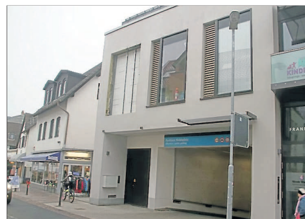
Die Außenfassade der Frankfurter Straße 58 hat bereits ein Loch erhalten, um den MRT aufnehmen zu können.
